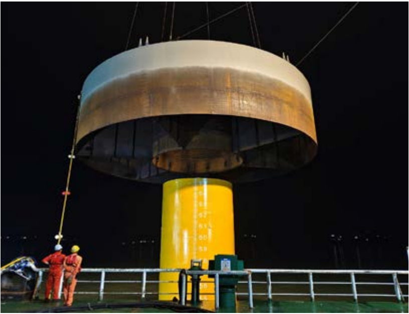
顺利完成项目首台负压桶体沉贯施工，负压桶体水平度在负压沉贯全过程控制在 2‰以内，达到世界领先水平
