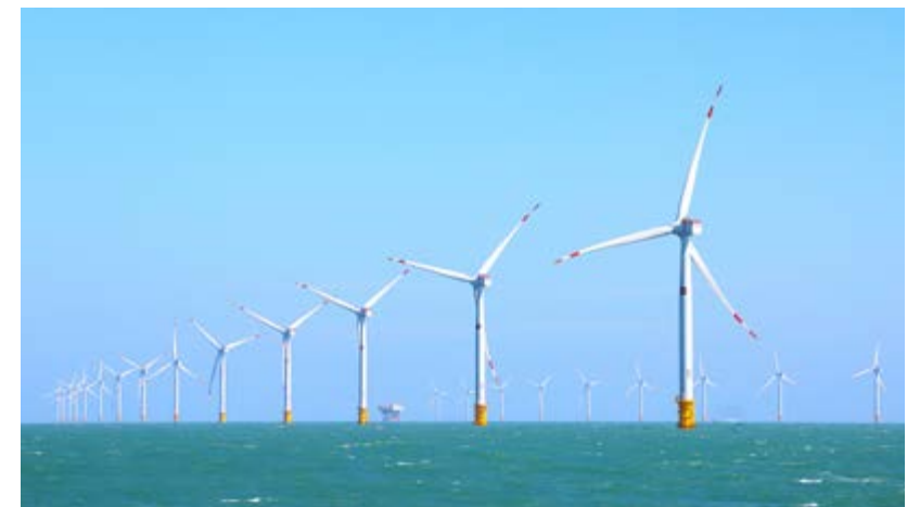
南澳勒门I海上风电项目
