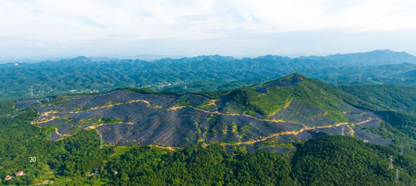
浙江分公司江山公司吕岗光伏项目
