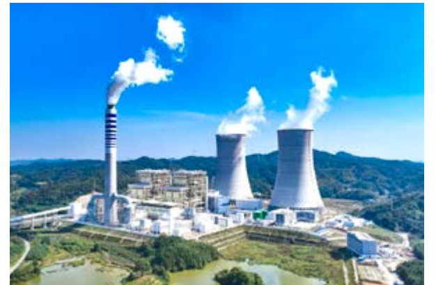
大唐新余二期2×1000兆瓦清洁高效煤电项目1号机组正式投产
